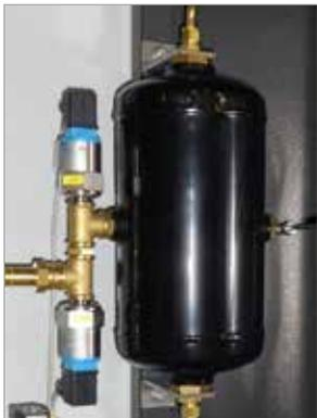
Специальный баллон, заполняемый азотом под давлением 8 бар, является опцией, необходимой для обеспечения безопасности при работе с водородом.
